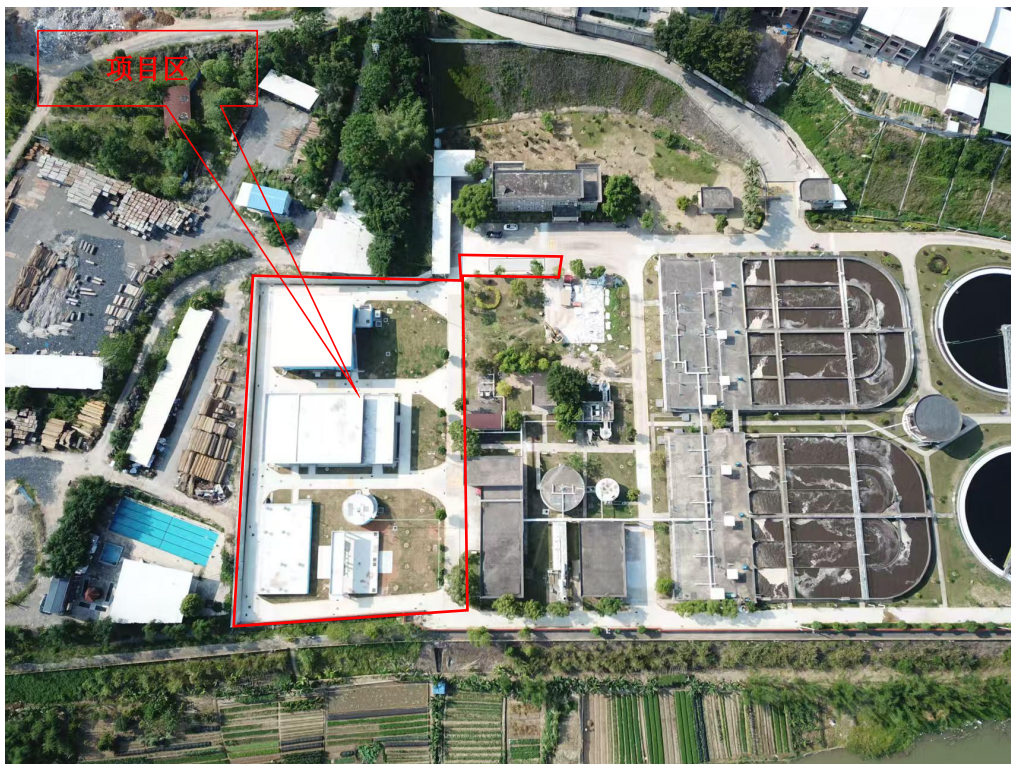
厂区整体航拍图
