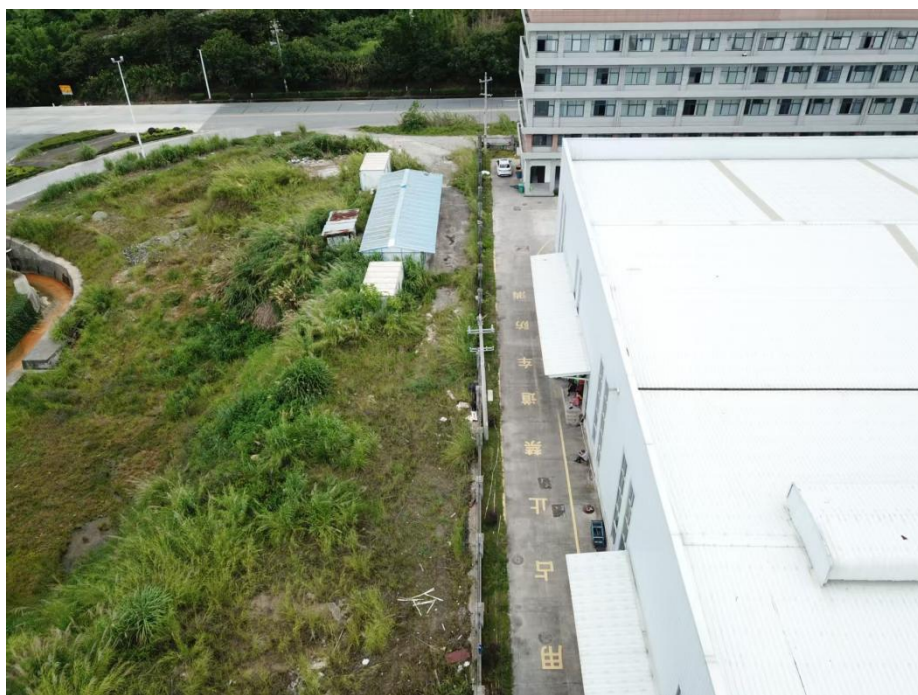
厂区南侧边侧
