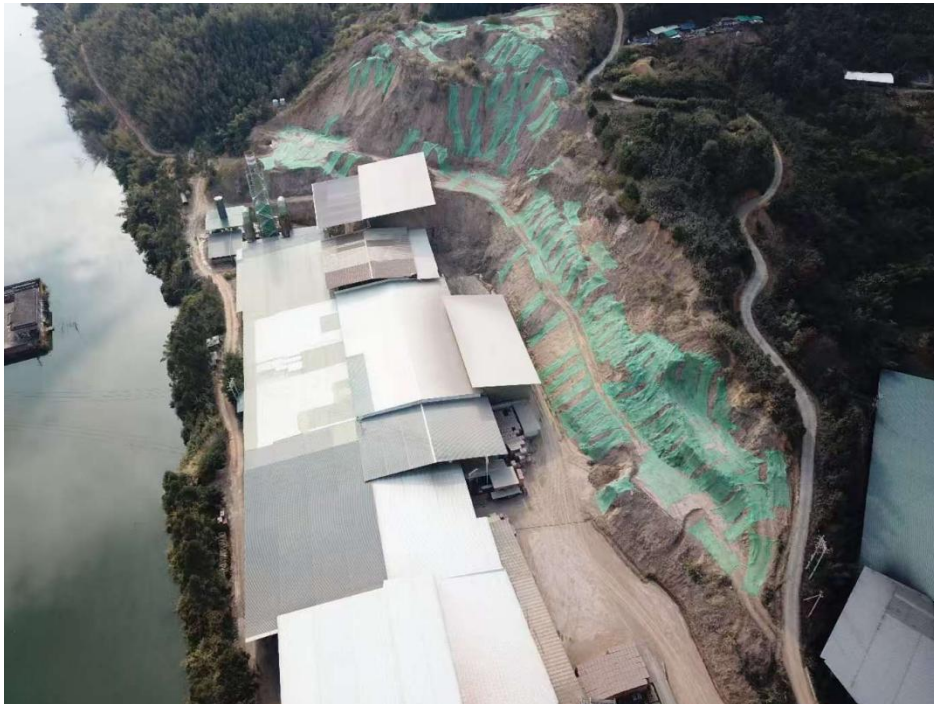
西侧边坡绿化及临时覆盖
