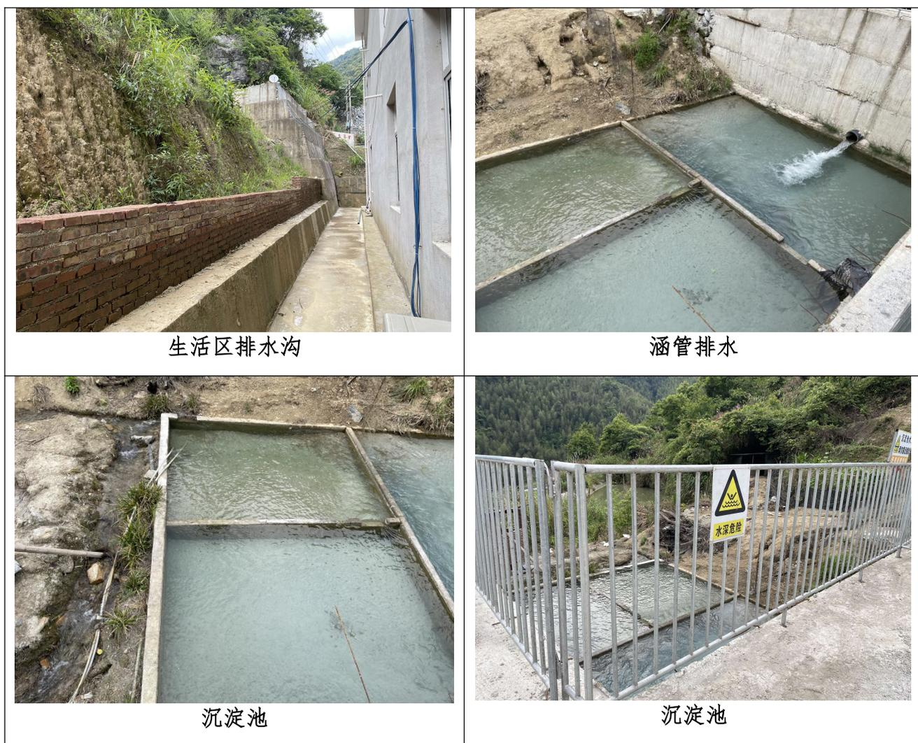
3、废石场、排土场周边建设有截排水沟、挡土墙、沉淀池，废水处理达标后外排或用于矿区洒水、清洗、绿化。（单项分3分）
