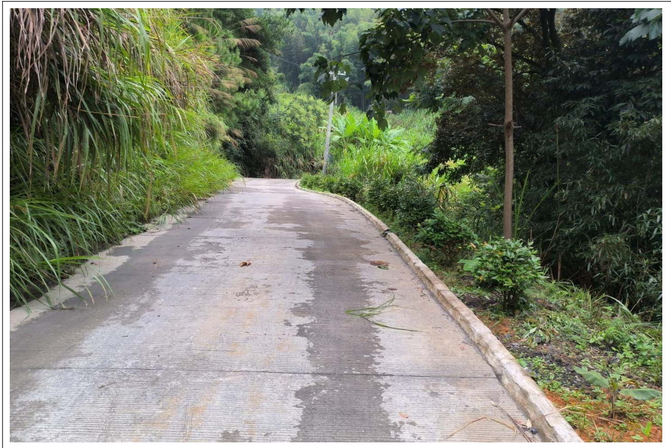
矿山永久道路及两侧行道树
