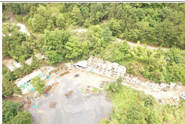
+608 洞口及项目部办公楼
