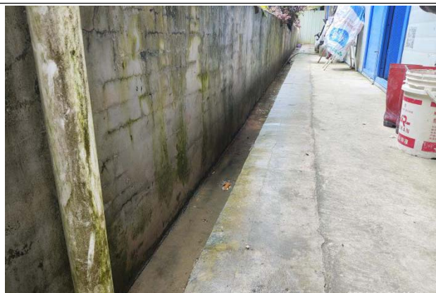
宿舍区排水沟
