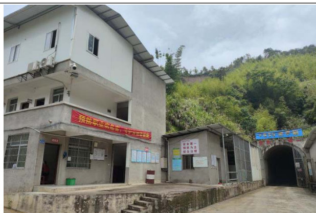
硐口安全警示牌
